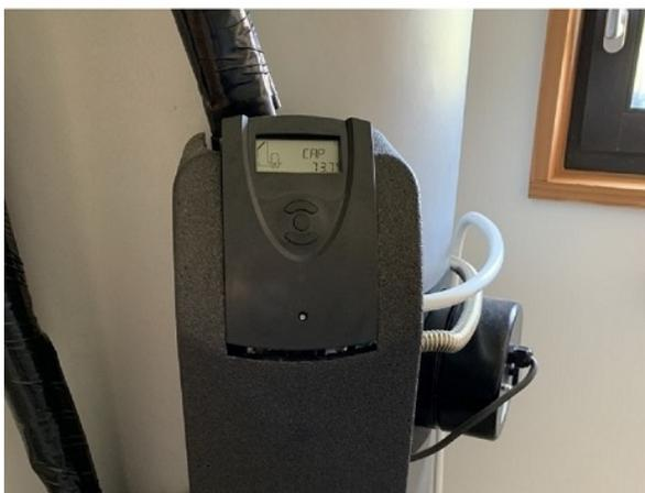
*Dans cette construction neuve en ossature bois de 120m<sup>2</sup> réalisée conjointement avec la coopérative de construction COCON, nous avons posé ce chauffe eau solaire de 300l avec 2 capteurs intégrés en toiture. Le CESI est certainement aujourd'hui une des meilleures solutions pour produire l'eau chaude sanitaire car le rendement est excellent et le système très fiable.*
